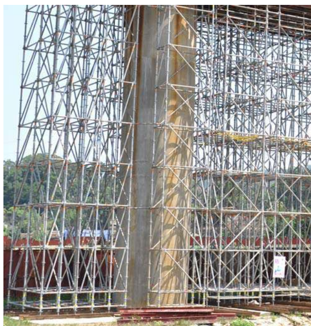
最下方圓盤架設橫桿補強
