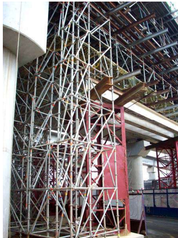
架設斜桿補強改正
