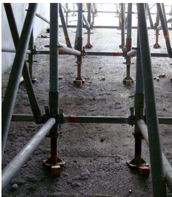
(14)下調整座在斜坡處使用三角楔木
