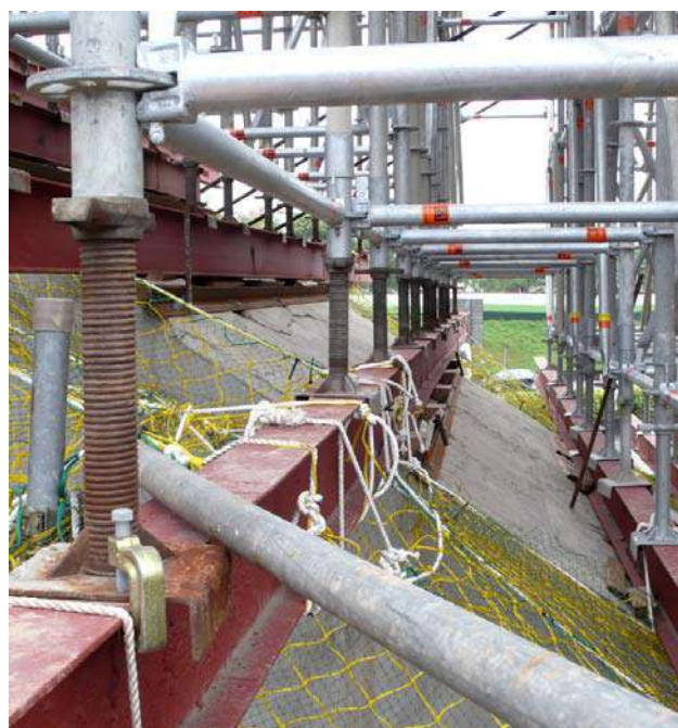
(15)下調整座在斜坡處使用 H 型鋼墊塊
