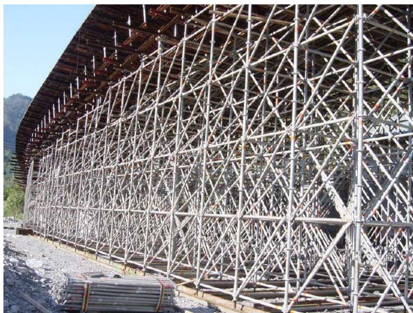
(7)工地實際斜桿架設同向情形
