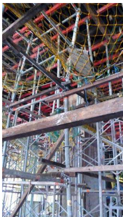
廠房支撐架未架斜桿，澆置後整體挫曲變形
