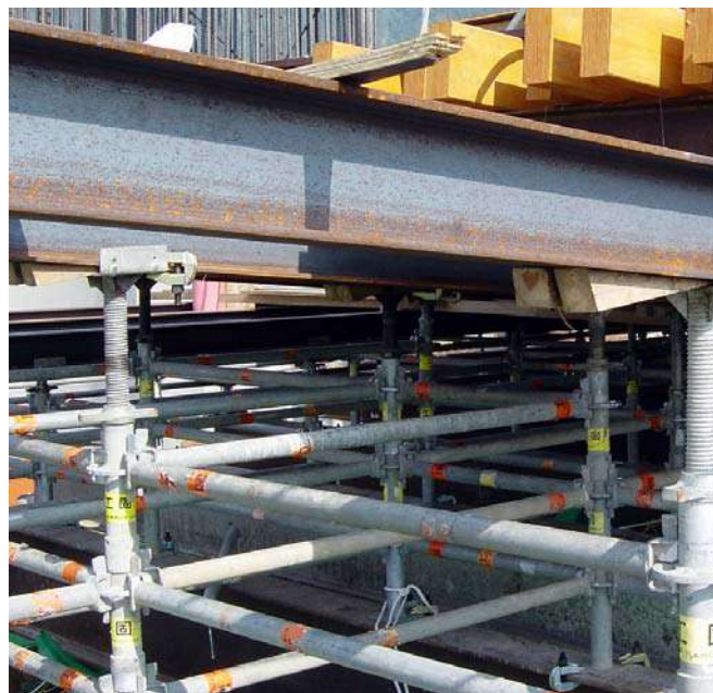
(13)U 型調整座配置使用三角楔木墊塊
