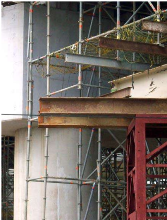
未架設斜桿，在澆置前已彎曲
