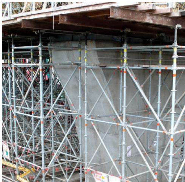
最上方圓盤架設橫桿補強
