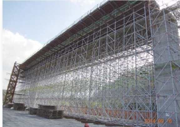
地鐵明挖覆蓋隧道頂版支撐
