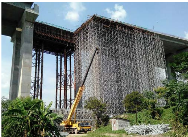
西濱WH10A-PYLON柱頭版支撐架 與施工架
