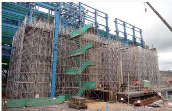
台北捷運CF643B標上構系統外模與支撐架工程
