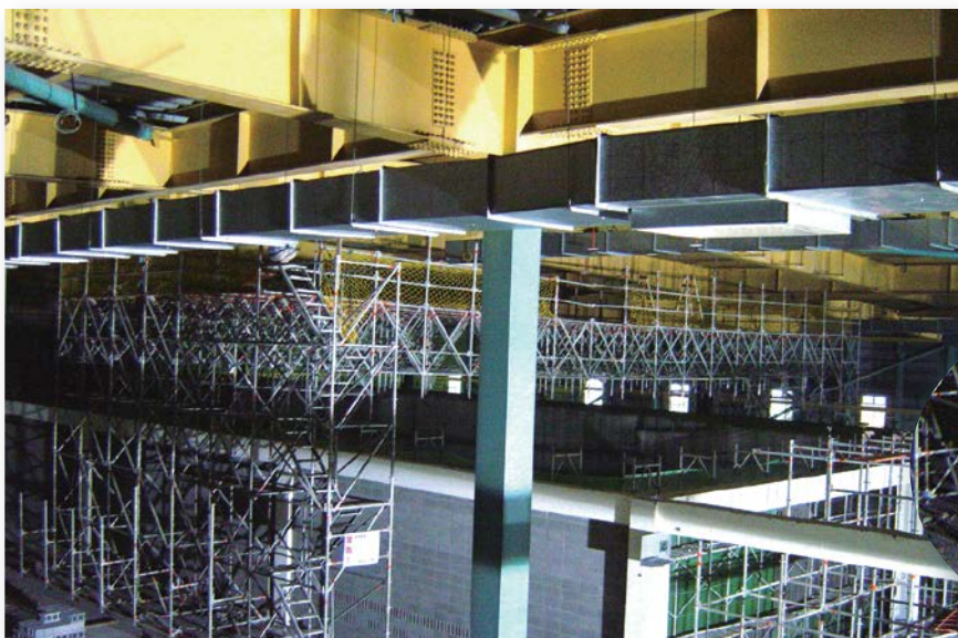
特高物流廠房裝設工程 ● (挑空、附滾輪可移動， 省時、省力、省成本)
