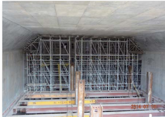
地鐵明挖覆蓋隧道頂版支撐
