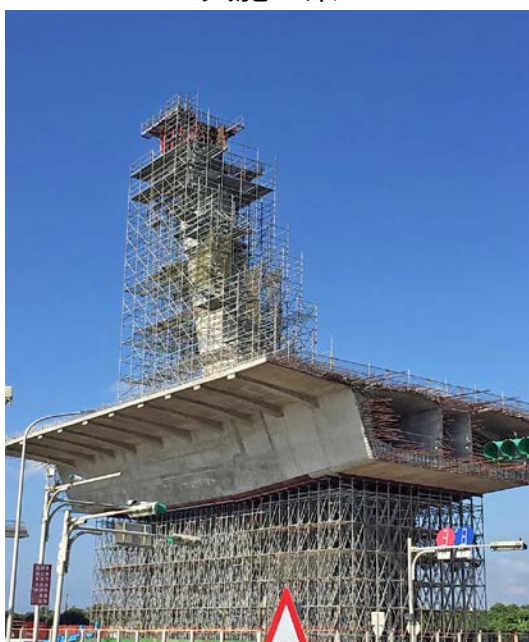
西濱WH10A-PYLON柱頭版支撐架 與施工架
