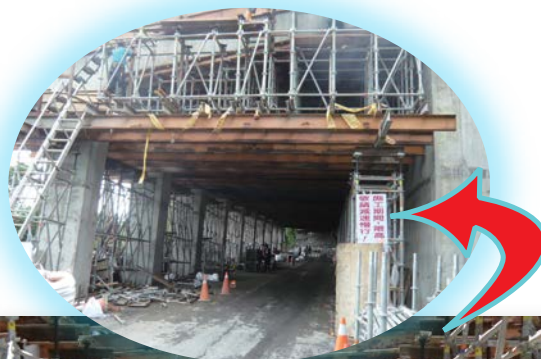
明隧道支撐工程
