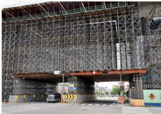
台北捷運CF642A標 Y型柱支撐工程
