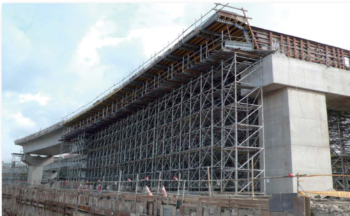
台北捷運CF643B標上構系統外模與支撐架工程
