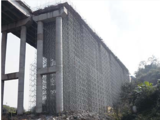
重慶清溪河大橋三跨連續 (高6~30m)支撐工程
