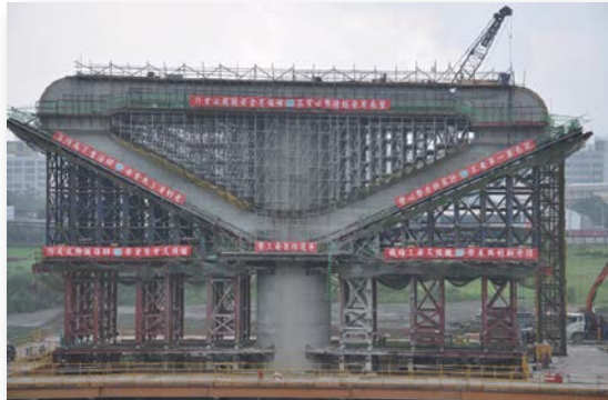
台北捷運CF643B標上構系統外模與支撐架工程
