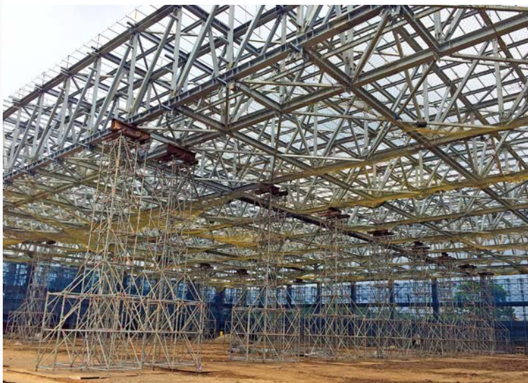
鋼構棚頂組裝臨時支撐工程
