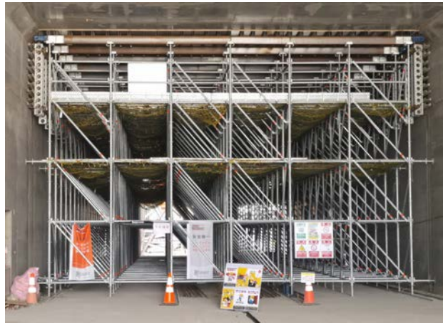
地鐵明挖覆蓋隧道頂版水平模結合支撐
