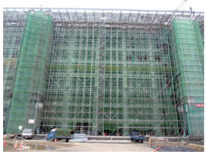
橋頭地方法院屋頂鋼構施工平台架
