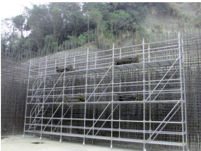
湖山配水池牆筋綁紮用施工架
