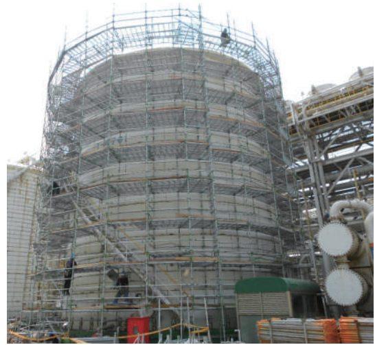
桶槽型外側包覆施工架
