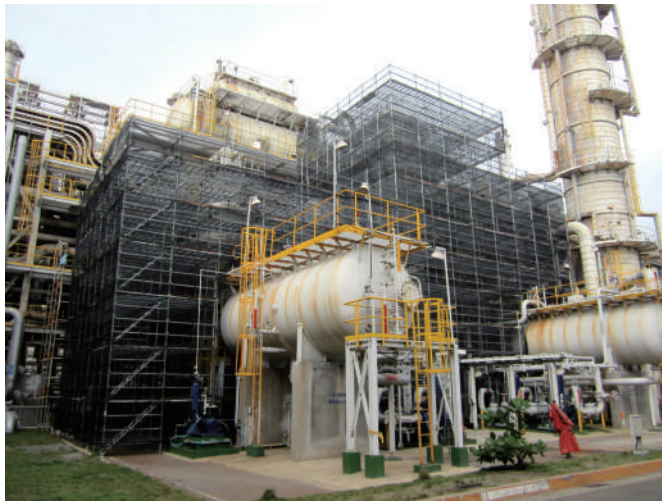
石化設備維修用施工架
