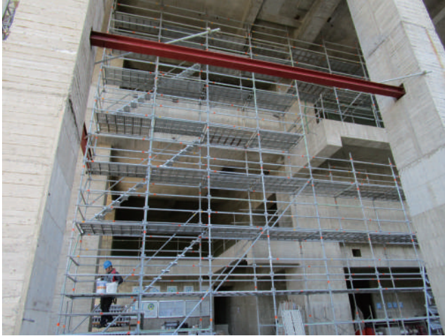
建築大樓外牆修飾用施工架
