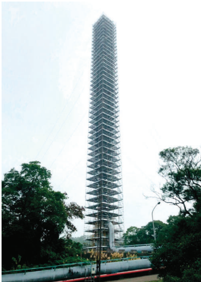
100m燃燒塔歲修用施工架
