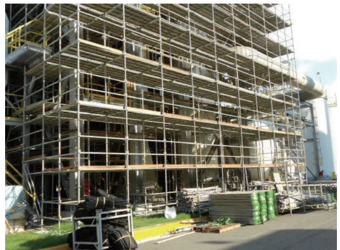
石化業管線歲修用施工架
