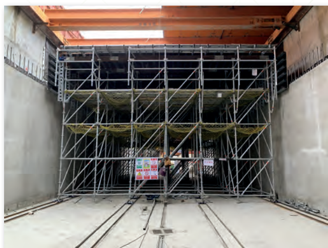
明挖覆蓋隧道頂版系統模板與支撐架工程
