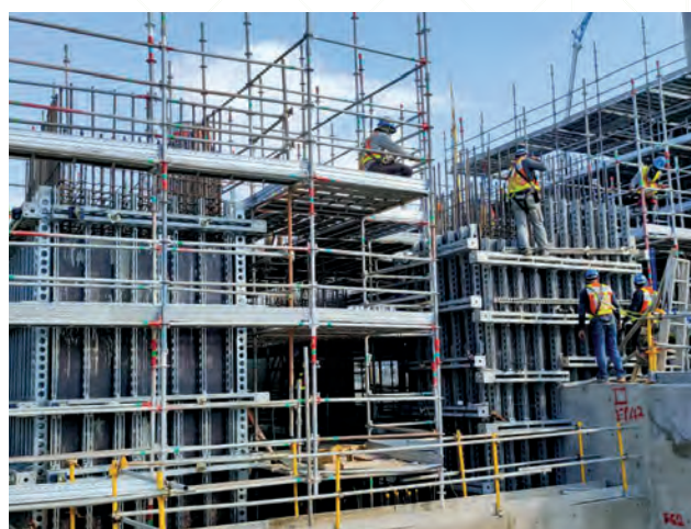
大潭電廠 7 號機 STG 室 5.3M 高柱模工程
