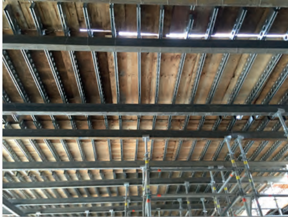
上頂梁在建築樓版模時，與 H 型鋼搭配作為次墊條用
