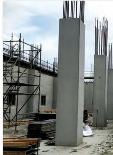
4.8M 高系統柱模 ( 完成面 )
