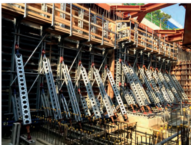
桃園龍潭 LY3 廠地下室 4.6M 高單面牆模工程
