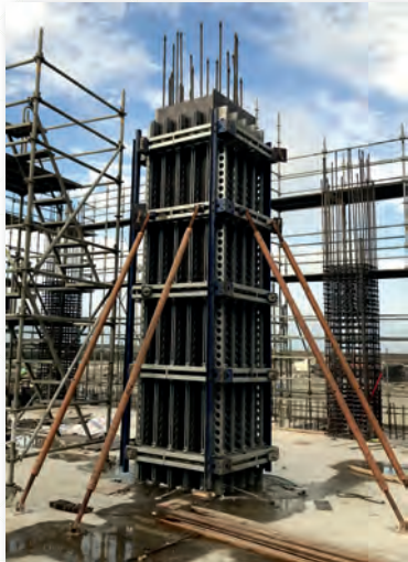
4.8M 高系統柱模 ( 施工中 )
