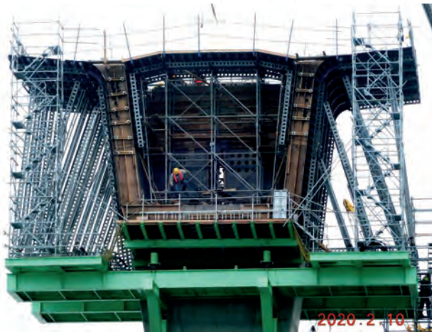
金門大橋柱頭版 (梁深 7.5M) 系統模板及上下設備工程
