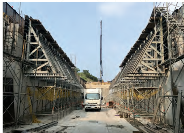
安坑輕軌單面牆模第二昇層工程
