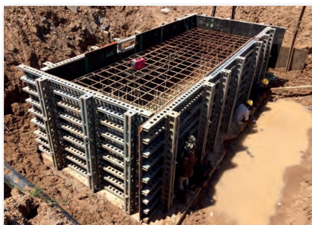
墩柱基礎系統系統模板工程
