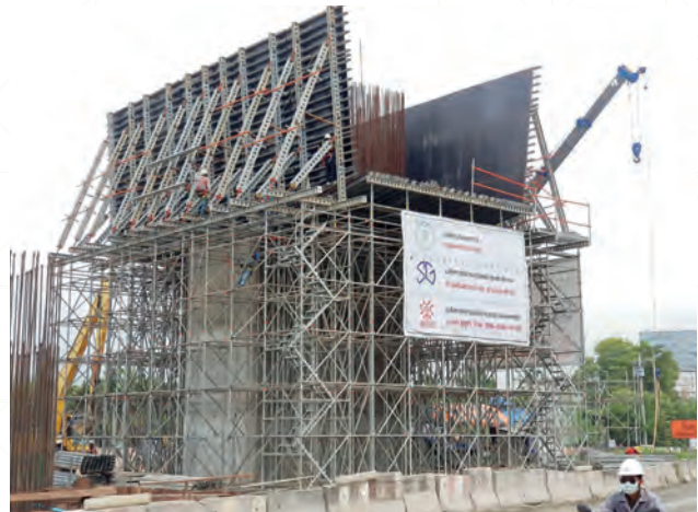
實固泰國懸臂工法橋梁之柱頭版 模板及支撐工程
