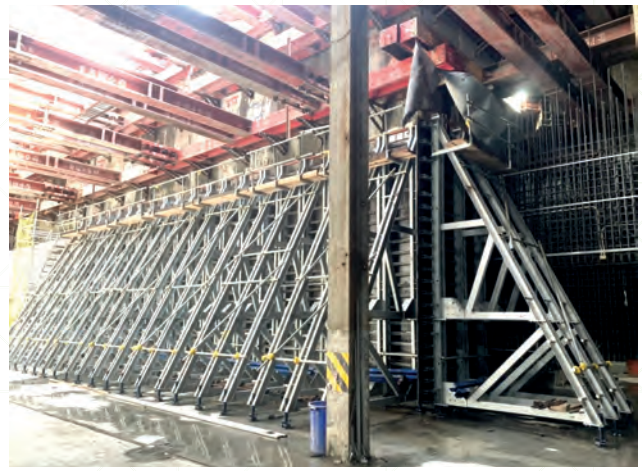
桃園機場捷運 GC02 標 6.0M 高單面牆模工程
