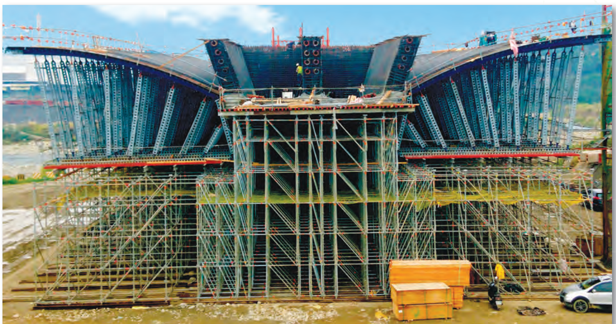
上頂梁於橋梁上構系統外模時，與蜂巢鋼搭配作為次墊條用
