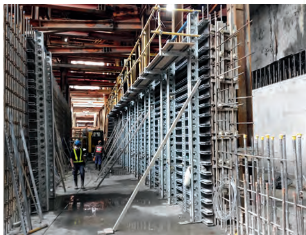
台北捷運萬大線一期 CQ872 標 中隔牆 4.5M 高雙面牆模工程
