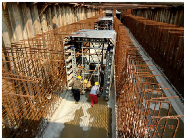
管道箱涵系統模板工程
