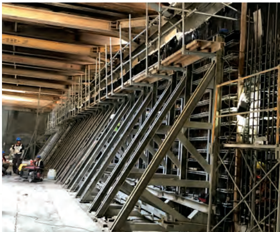
安坑輕軌單面牆模第一昇層工程
