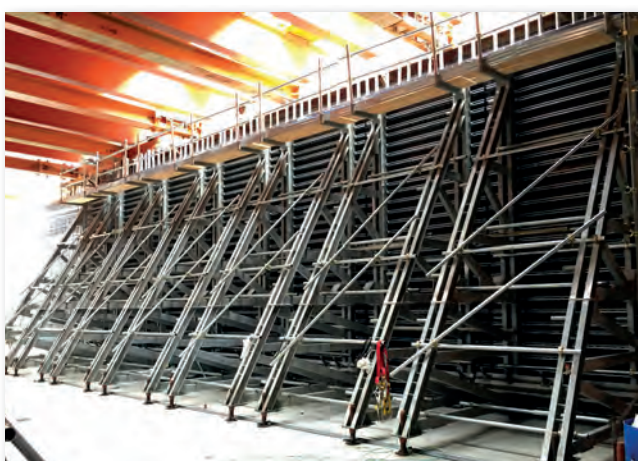
台南鐵路地下化 C214 標 6.0M 高單面牆模工
