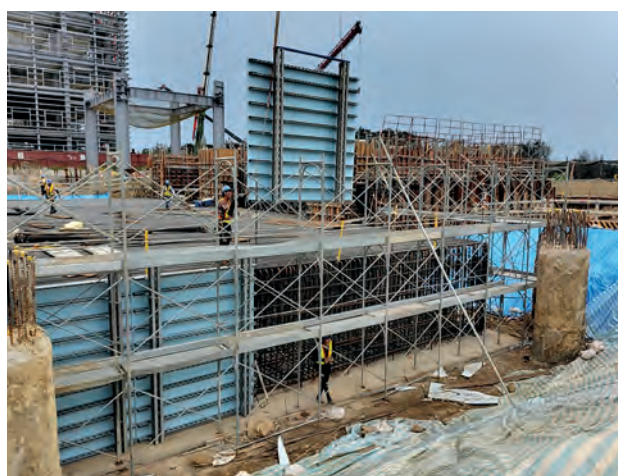
大潭電廠 7 號機 STG 室 3.05M 高基礎模工程
