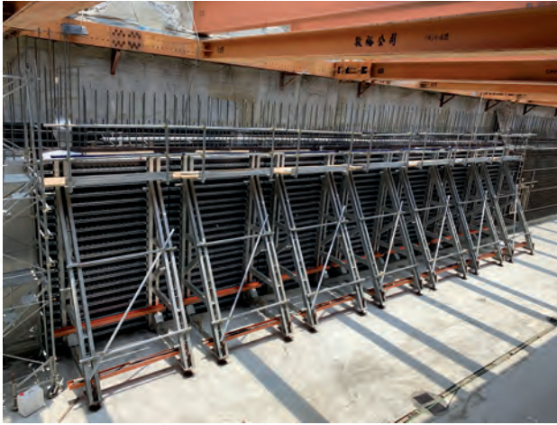
台南鐵路地下化 C211 標 4.5M 高單面牆模工程
