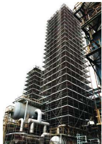
52M 石化廠區維修工程
