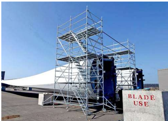
風機葉片施工架
