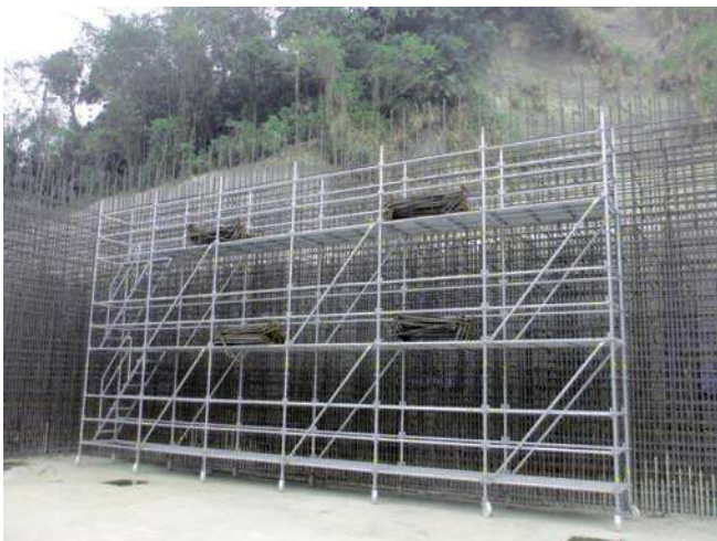
湖山配水池牆筋綁紮用施工架
