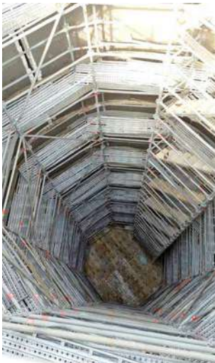
墩柱施工架
