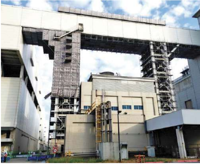
圓桶槽型施工架
