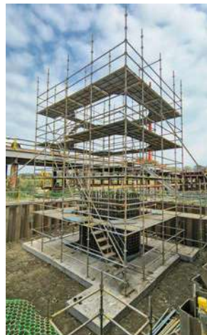
墩柱施工架
