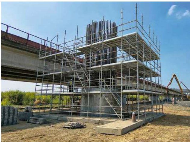
墩柱施工架
