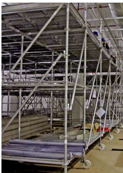
移動式施工平台架
