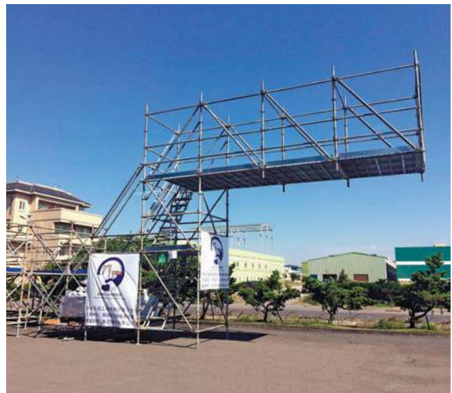
單邊懸臂 5.4m 施工平台
