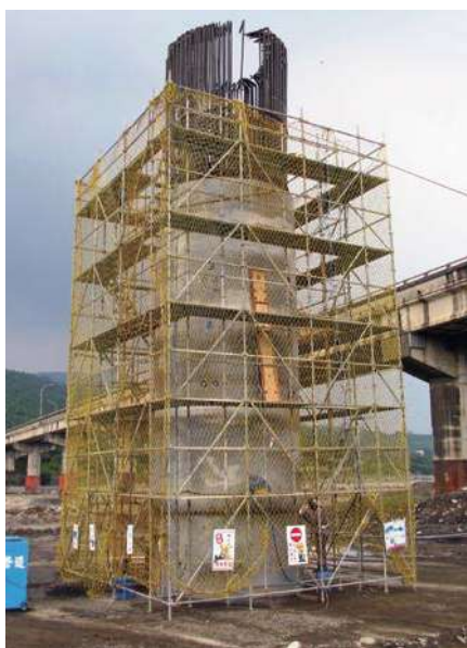
墩柱施工架
