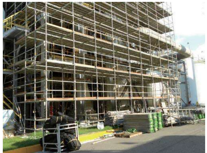
石化業管線歲修用施工架
