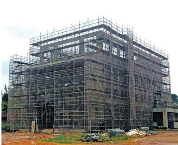
實固公司沙鹿物流廠建築施工架
