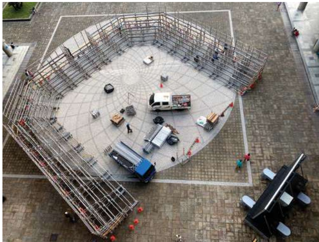
科博館戶外表演看台 ( 搭設中 )
