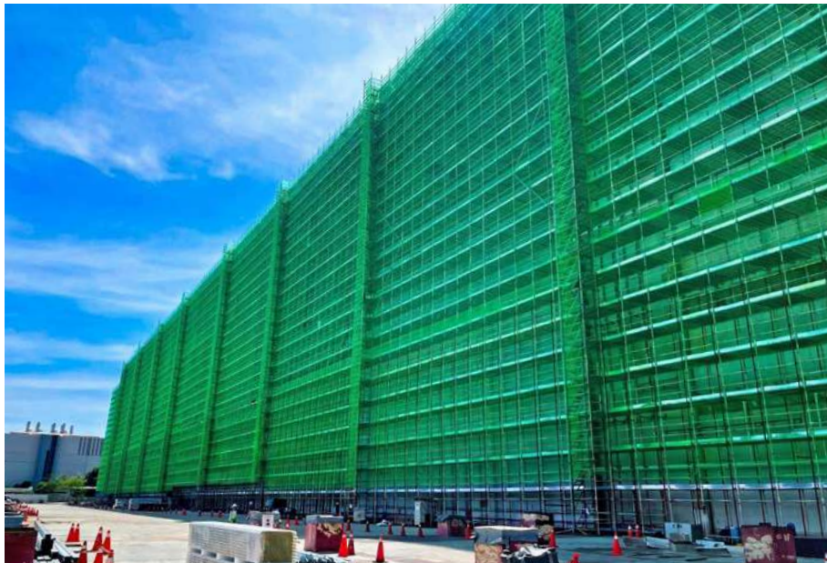
建築結構外牆系統施工架
